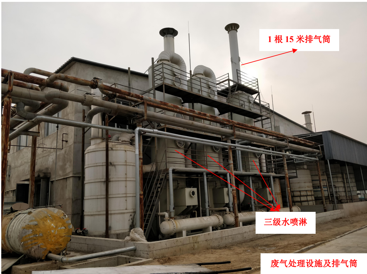
图 3-5 一车间和二车间废气处理设施现场照片
