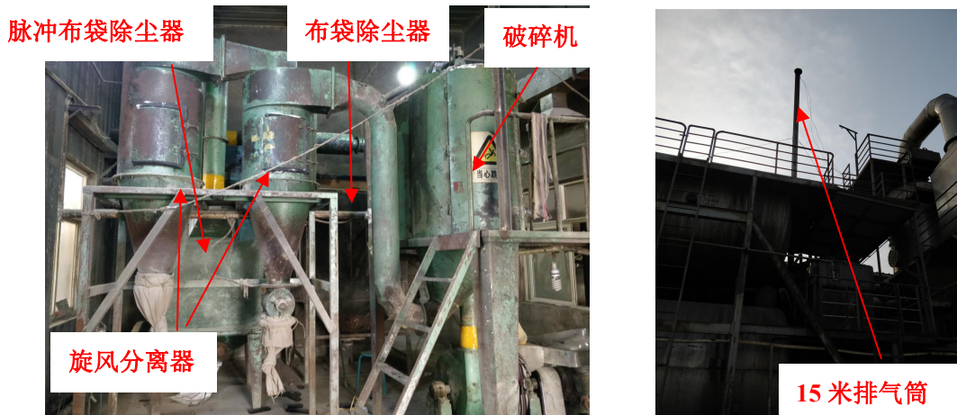
图 3-13 三车间粉碎工序废气处理设施现场照片
