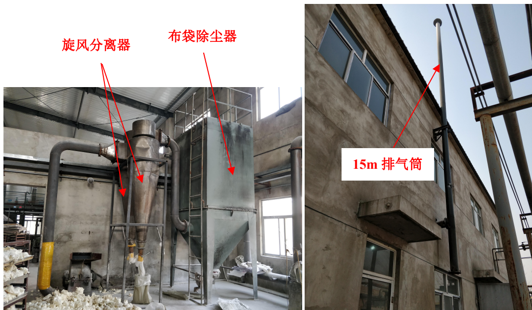
图 3-7 一车间粉碎工序废气处理设施现场图片
