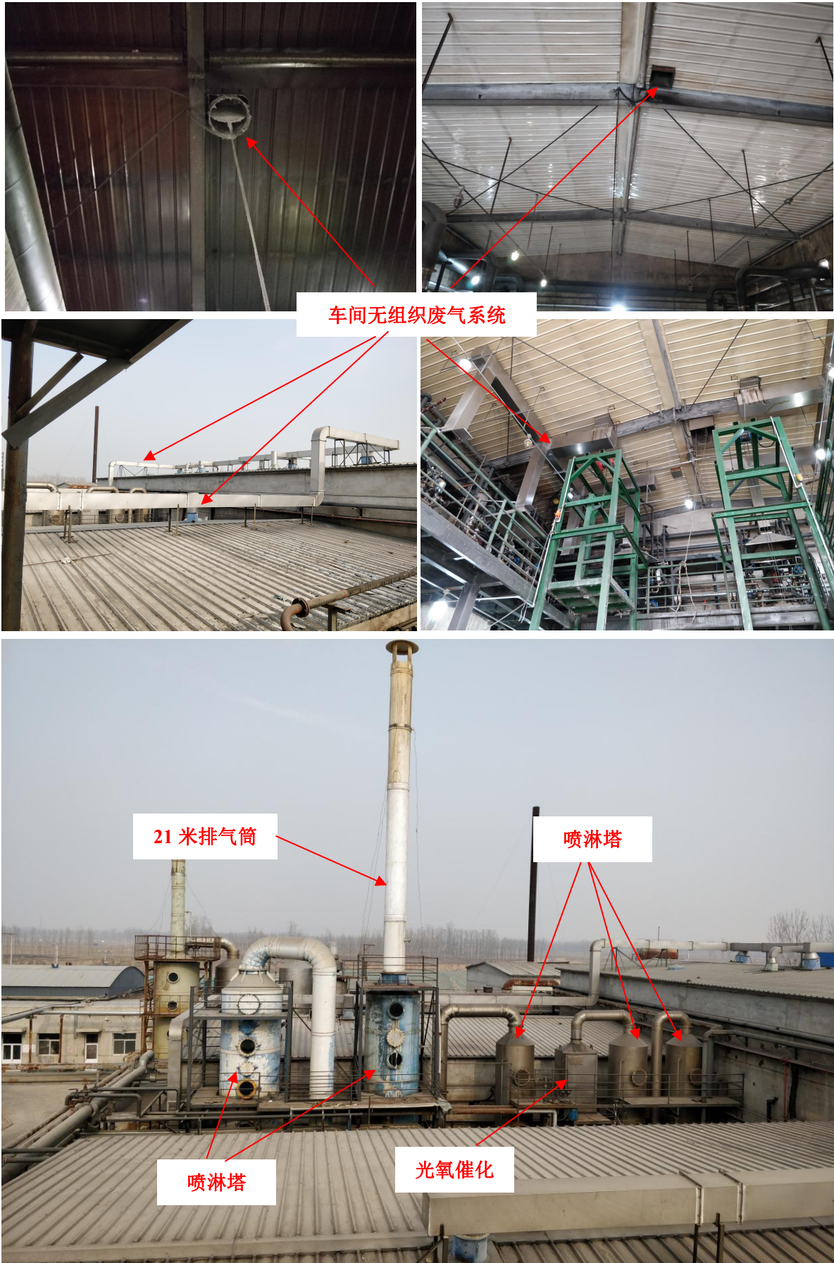
图 3-9 三、四车间反应釜及车间废气处理设施现场照片
