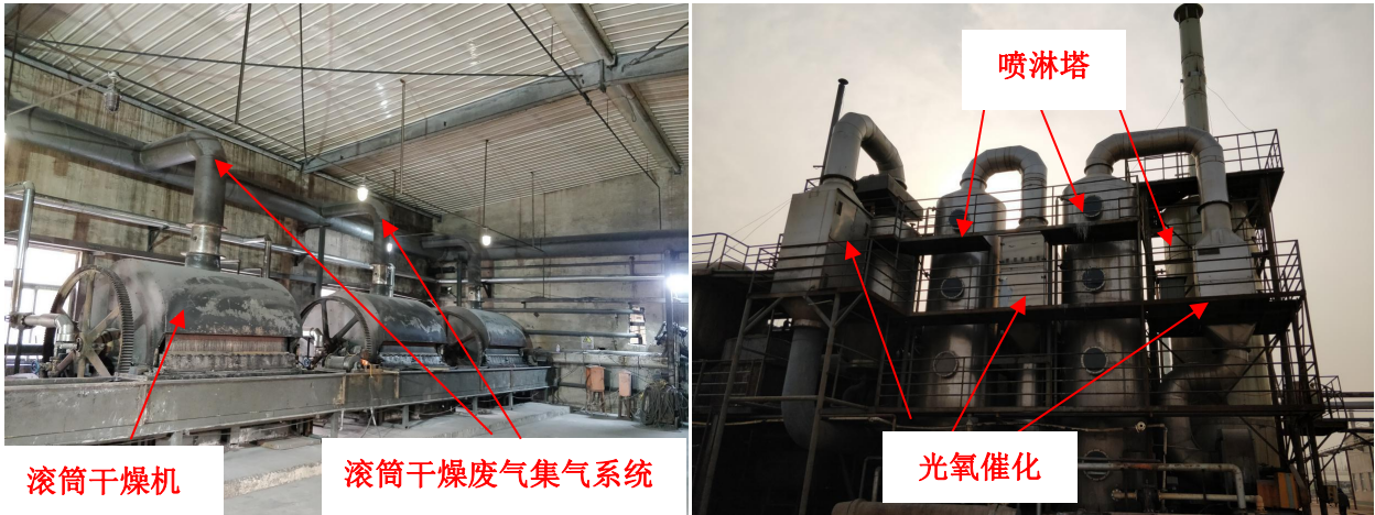
图 3-11 HS-1 滚筒干燥车间废气处理设施现场照片
